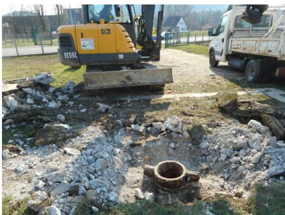
Figure J- 13 : Tête du sondage n°20 dégagée
